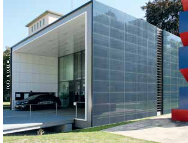
Das Energie-Plus-Haus in Berlin mit Stromtankstelle
