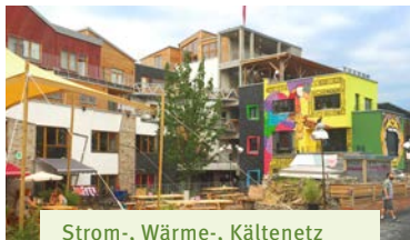
Strom-, Wärme-, Kältenetz
