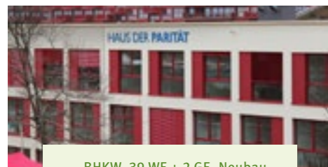
BHKW, 39 WE + 2 GE, Neubau
