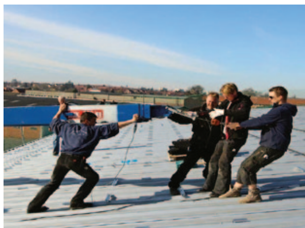
Zukunftsgenossen eG beim Bau Ihrer ersten Photovoltaikanlage
